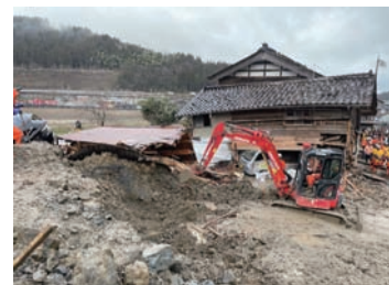
重機活動状況
